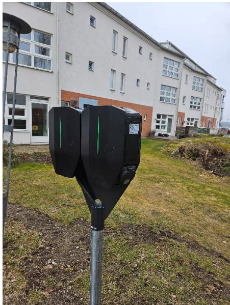
Figur 3: Arbetet med att bygga upp en egenägd laddinfrastruktur har påbörjats.
