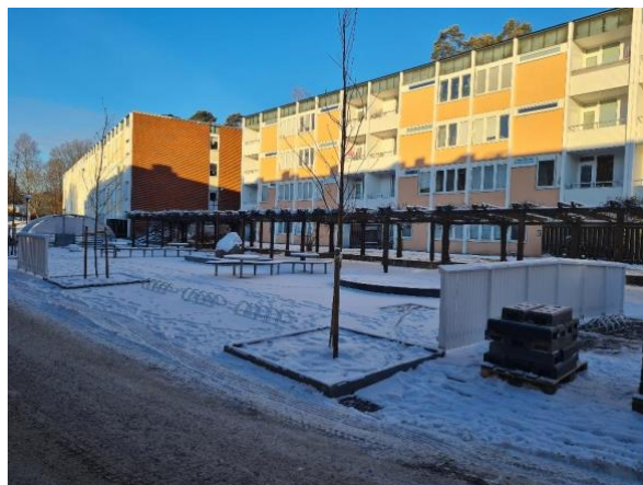
Figur 6: Höglundavägens torg efter upprustningen.
