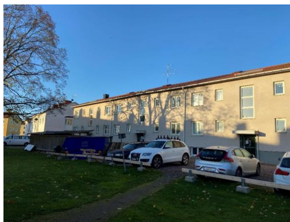
Figur 5: Kanotgymnasiet internat på Ringvägen, Fågelbo, har genomgått en stor invändig ytrenovering.
