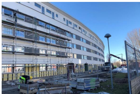
Figur 3: Delar av Ortvägen, Brandkärr har försetts med nya fönster och ny fasadbeklädnad med tilläggsisolering.
