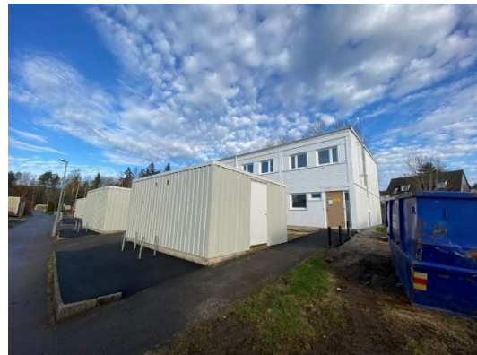
Figur 1: Renovering av radhus på Kamomillgården, Arnö har nått sin andra etapp.
