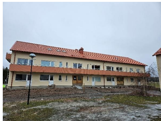
Figur 2: Renovering av Stationsvägen 7, Tystberga
