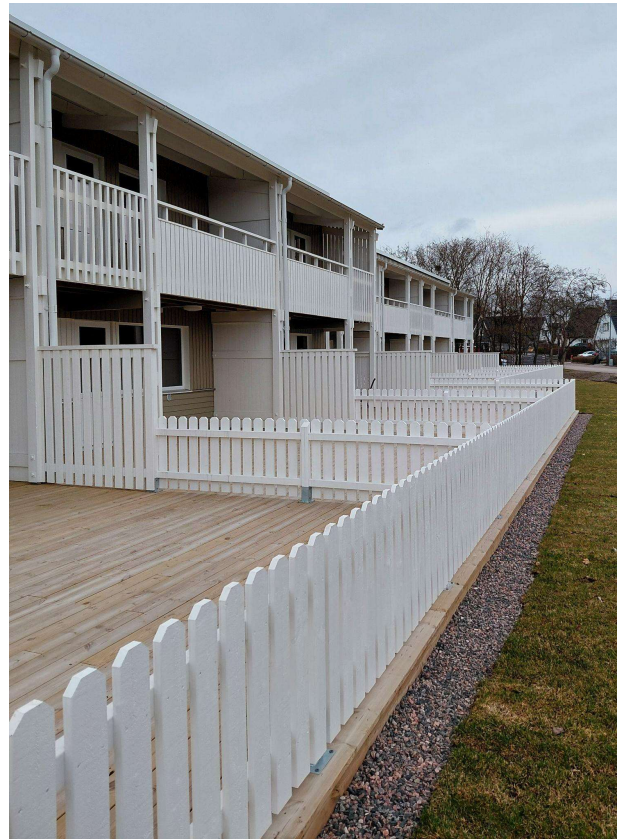
Figur 2: Renoveringarna av radhus på Arnö. Fortsätter med Blåklintsvägen.
