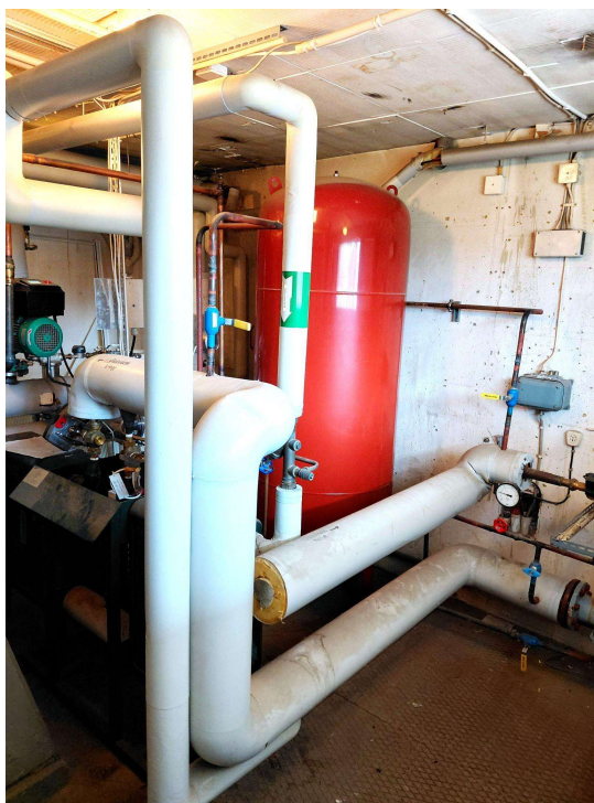
Figur 3: Undercentral med AI-styrning för optimerad värmetillförsel.
